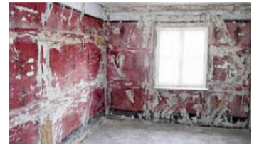
Blick in die Stube im Haus Nr. 5.
