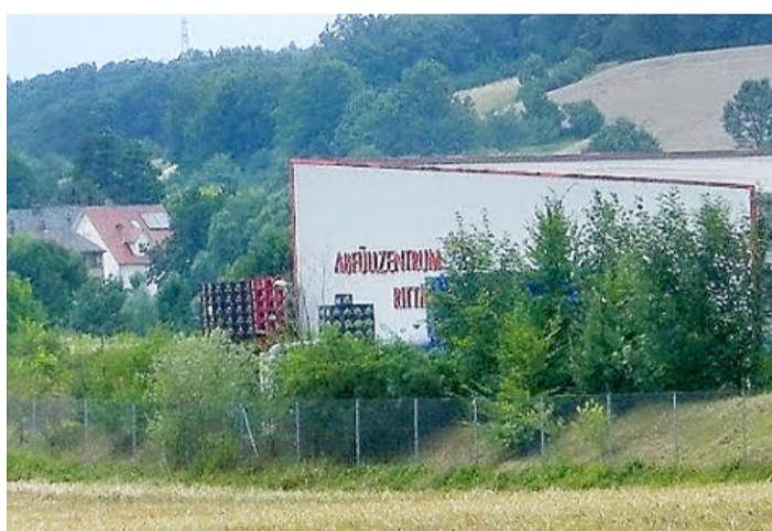
Noch steht hier nur eine Abfüllanlage; die Brauerei Rittmayer will dort aber ihre Brauerei neu bauen. Foto: Wildt
