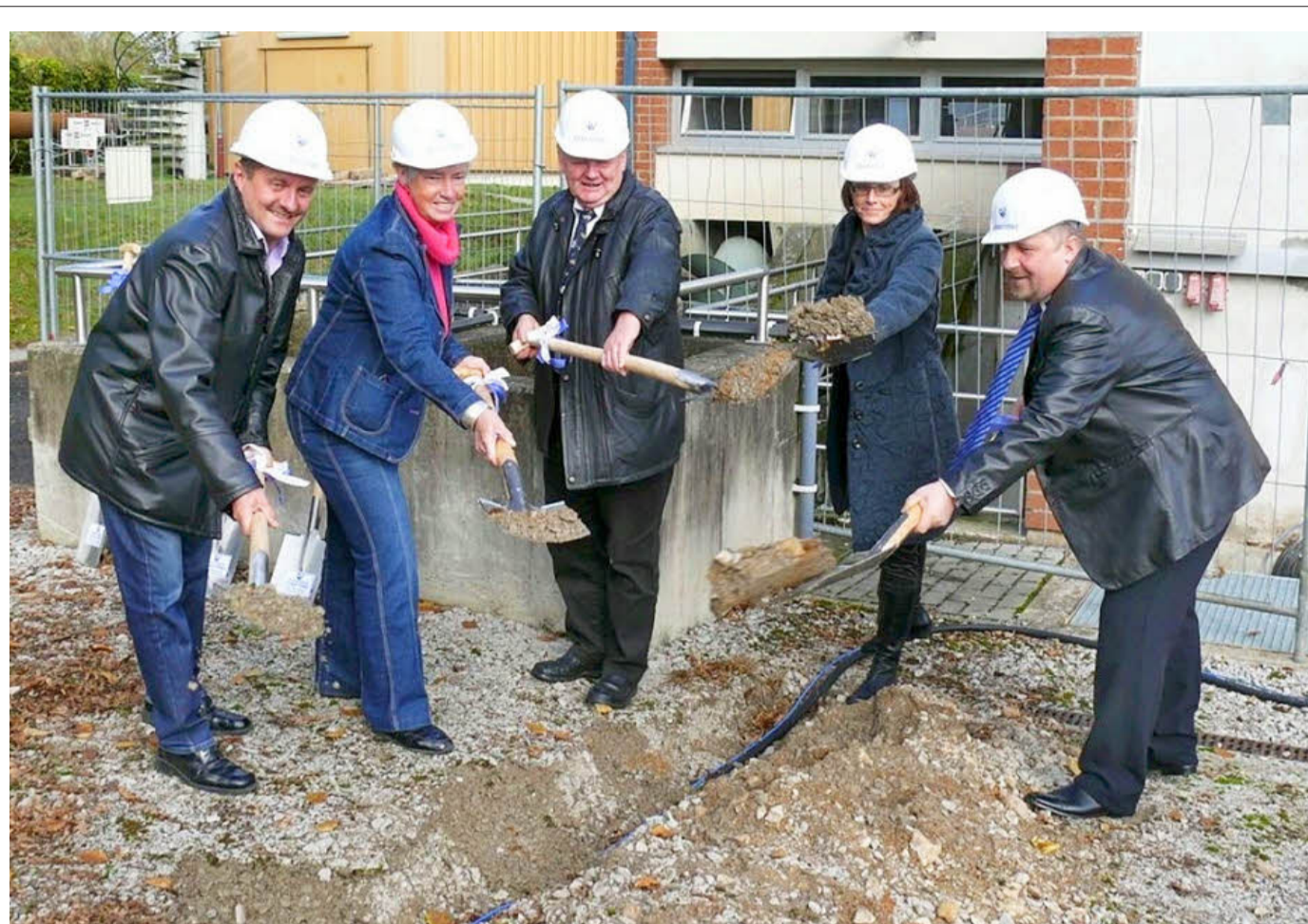
Die Bürgermeister griffen zum Spaten. Von links sind zu sehen Wolfgang Fees (Langensendelbach), Gunhild Wiegner (Poxdorf), Richard Schmidt (Effeltrich), Vize-Bürgermeisterin Petra Lobenhofer-Brixner (Marloffstein) und Andreas Galster aus Baiersdorf. Foto: Anja Schobert
