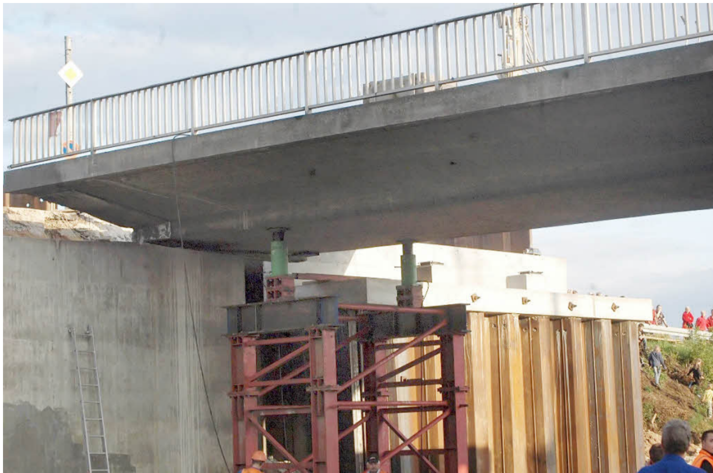
Die bisherige Jahnbrücke wurde angehoben und um zwölf Meter in Richtung Süden verschoben. An ihrer Stelle entsteht ein Neubau. Foto: hit
