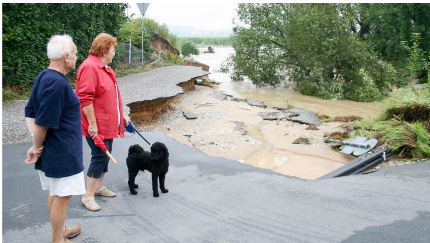
Fassungslos standen die Leute vor den Schäden, die das Hochwasser in der Nacht zum 21. Juli 2007 angerichtet hatte.
