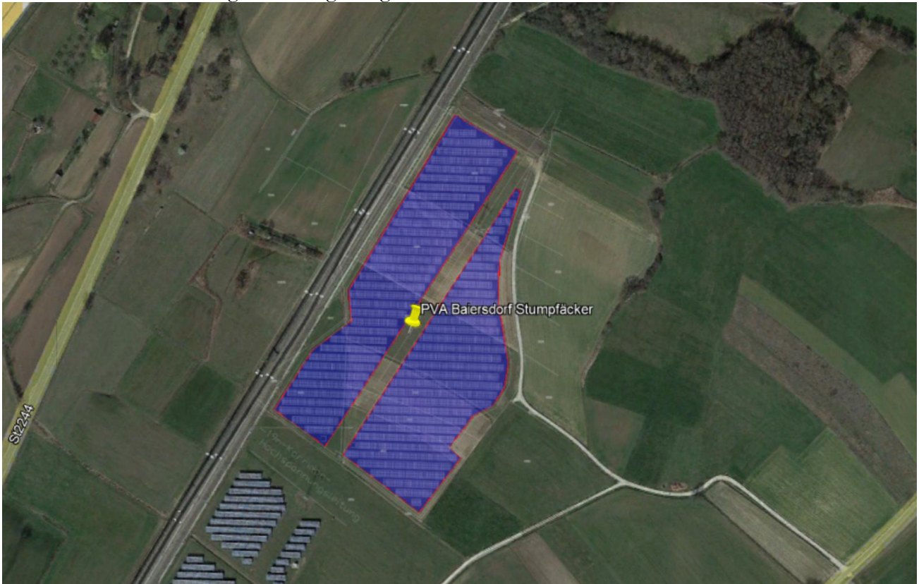
Bild 2.1.2: Detailansicht der PV Fläche (Quelle: Google Earth/SolPEG)
