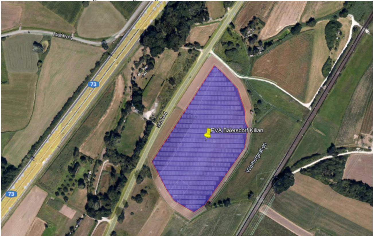
Bild 2.1.2: Detailansicht der PV Fläche (Quelle: Google Earth/SolPEG)
