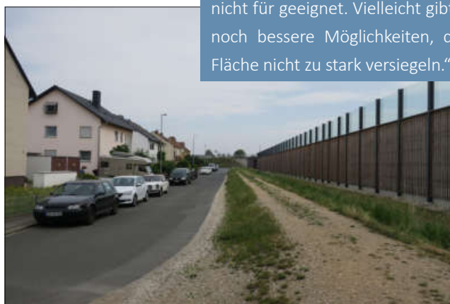
Abb. 5.10. Eindrücke Bestandssituation Lärmschutzwand
