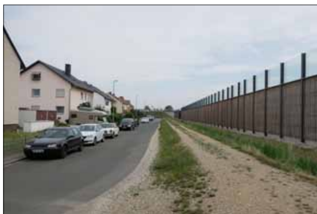
Abb. 5.10. Eindrücke Bestandssituation Lärmschutzwand
