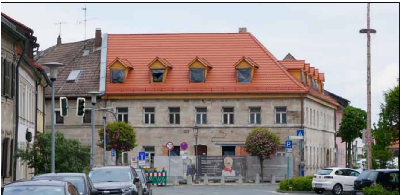
Abb. 5.1. Haus Judengasse 1 – Beispiel für ein sanierungsbedürftiges Gebäude
