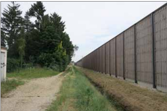
Aktueller Zustand der Lärmschutzwand
