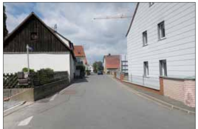
Abb. 2.24. Igelsdorf, Ortsdurchfahrt ohne Bürgersteig
